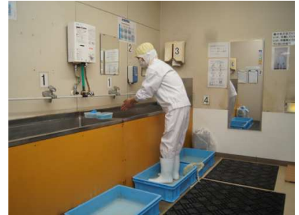
③手洗い場・長靴殺菌槽（消毒槽）
